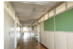
校舎はほぼ原型を残しており、懐かしい気持ちに。施設はイベントだけでなく、シェアオフィスや撮影のロケにも使用されている。
