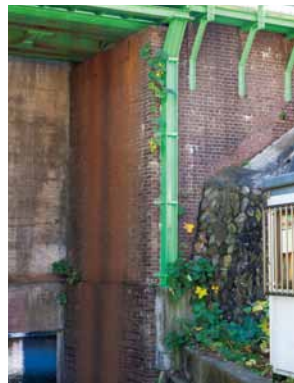
上/暗渠だった用水を6年ほど前に開渠化して流れが見えるようになった。下/緑線をくぐる日野用水の両側に重厚なレンガを見ることができる。
